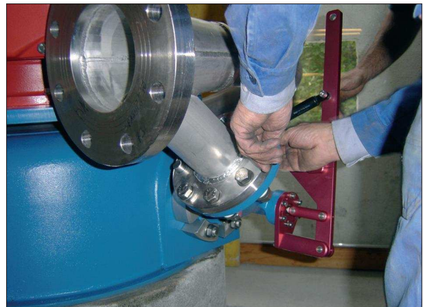
Montage d'une Turbine Pelton
